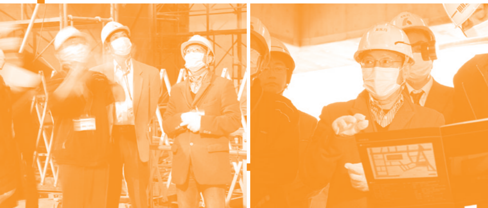
昨年11月下旬、野田芸術監督が建設現場を視察。ほり舞い立つ改修現場につき全員マスク着用。(左)右端、(右)中央
