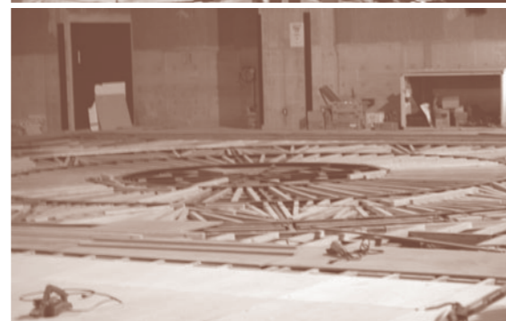
【上】ステージ下手側からの眺め。足場が張り巡らされ元の面影がまったくないが、改めて空間の大きさを感じる。 【下】ふだんは見えない舞台機構が見られるのも工事中ならではの。
